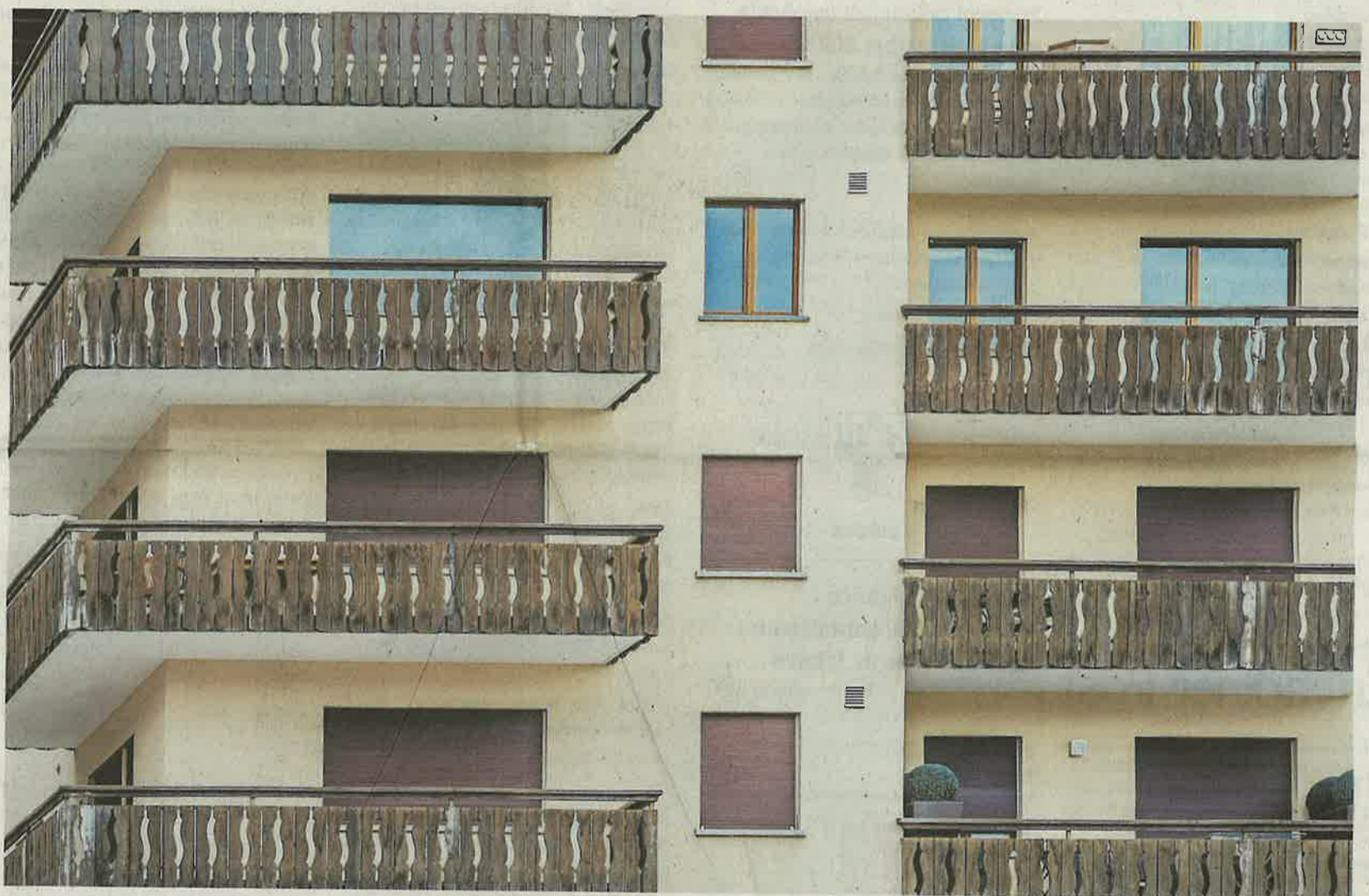
Leerstehende Wohnungen, die durch Lenkungsabgaben belebt werden sollen.
